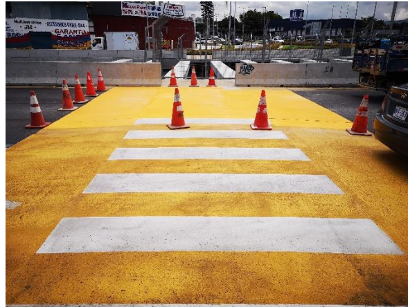
Figura 49. Reparación pintura paso peatonal. Fuente LanammeUCR, 2020.
