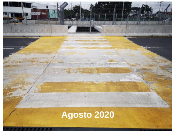
Figura 43. Condición de deterioro, desprendimiento de demarcación horizontal en cruces peatonales evidenciado durante los meses de julio y agosto 2020. Fuente LanammeUCR,2020.
