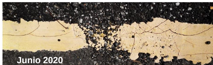
Figura 43. Condición de deterioro, desprendimiento de demarcación horizontal en cruces peatonales evidenciado durante los meses de julio y agosto 2020. Fuente LanammeUCR,2020.
