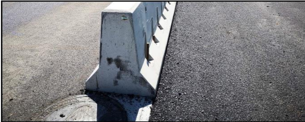
Figura 42. Barrera de concreto en mediana, paso inferior del proyecto Intercambio Garantías Sociales. Fuente: LanammeUCR, 2020.
