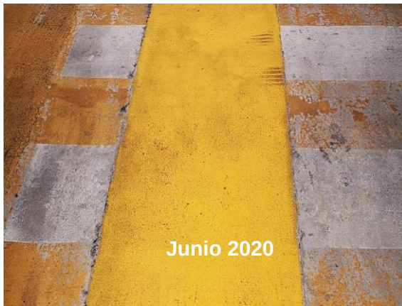
Figura 43. Condición de deterioro, desprendimiento de demarcación horizontal en cruces peatonales evidenciado durante los meses de julio y agosto 2020. Fuente LanammeUCR,2020.
